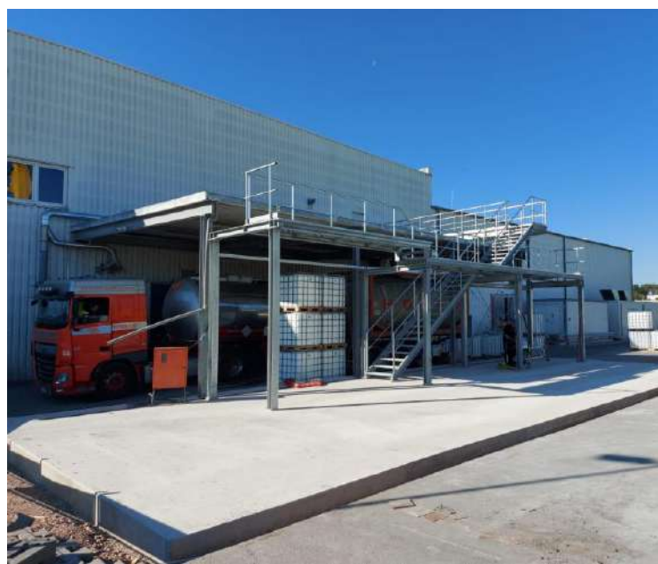
4x WRT-CONTAINER inkl. kplt. Stahlgerüst + Treppenaufbau + Übergang in Bestandsgebäude
